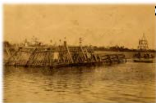
写真：水制工の組み立て風景
