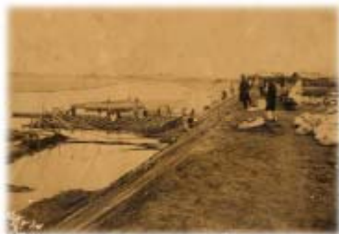
写真：粗朶沈床作成風景
