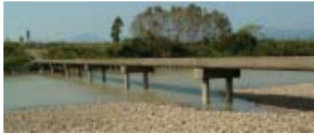
写真：千田潜水橋
