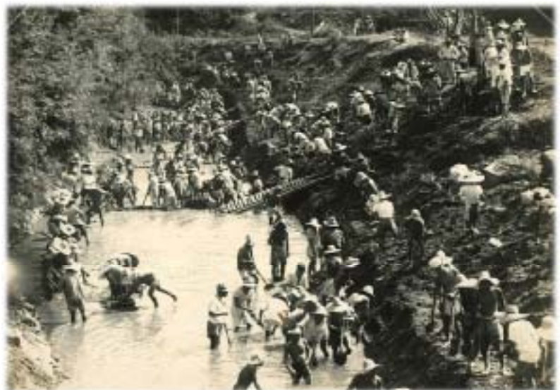
写真：工事の風景
