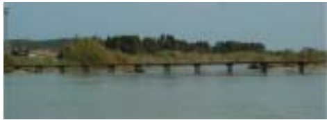
写真：柳瀬潜水橋
