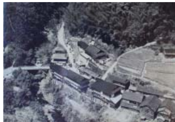
写真：道路に接して建てられた住宅
