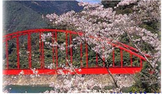
写真：一ツ瀬11橋
