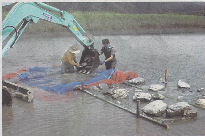
友内川で行われた石倉の設置作業（11日、延岡市無鹿町）
